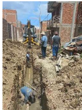
CAMBIO DE RED DE ALCANTARILLADO SANITARIO
